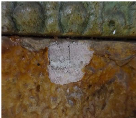
MG 12. I MG 13. Trencaments del suport per xoc mecànic. -cops-
