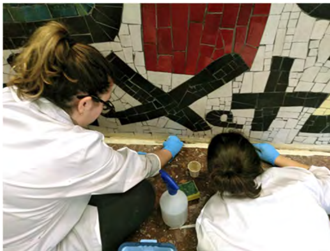
MT 32. Aplicació morter de l'angle amb terra
