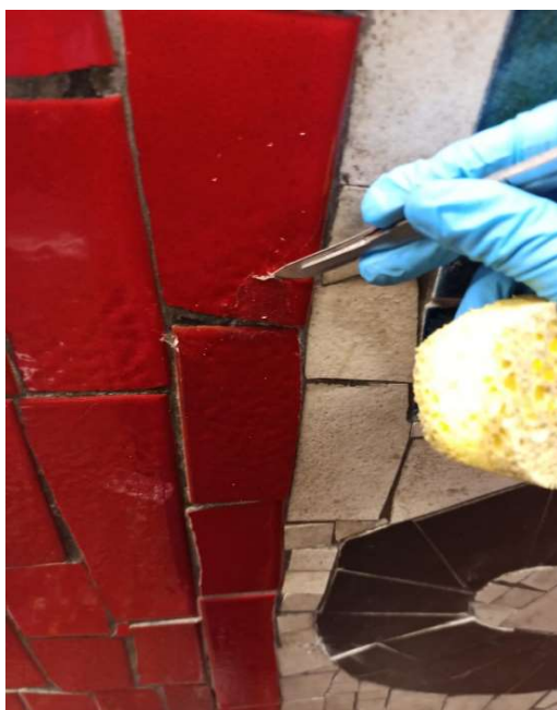
MT 19. Proves de neteja puntual amb bisturí per Silicona adherida.
