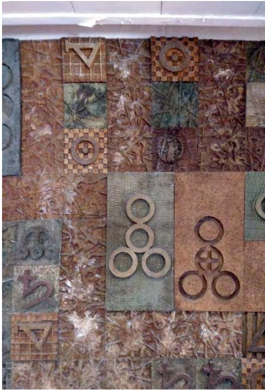
MG 9. Evidència d'humitats anteriors des de dalt.
