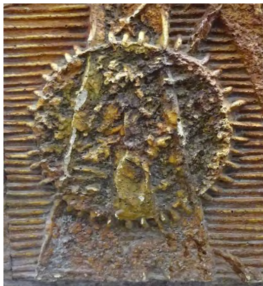
MG 25. Trencament, desgast, alteració del color per brutícia contaminant
