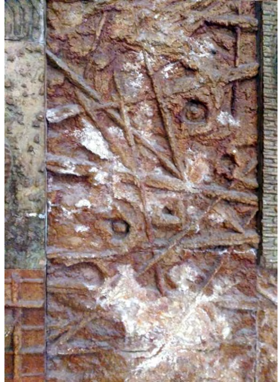
MG 10. Detall de les eflorescències salines
