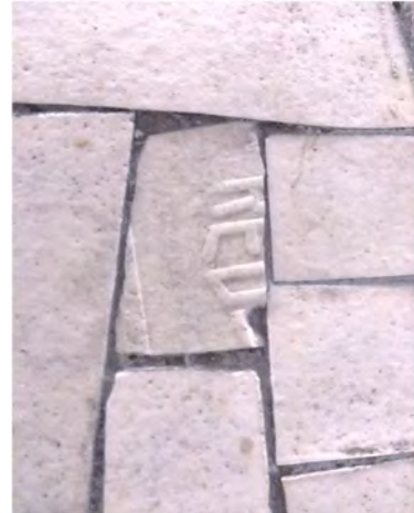
Ceràmica Gres Porcellànic. Aquesta peça col·locada del revés mostra la marca comercial (no identificada) en relleu.
