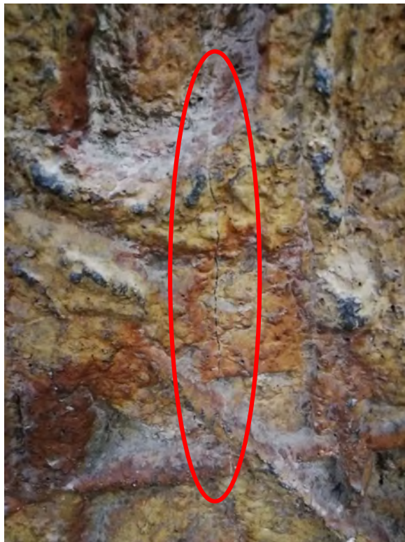
MG 5. Esquerda intrínseca del suport
