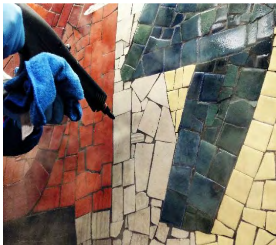
MT 17 Prova de neteja amb vapor calent d'aigua
