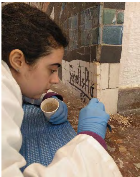
MT 31. Aplicació del morter de junt
