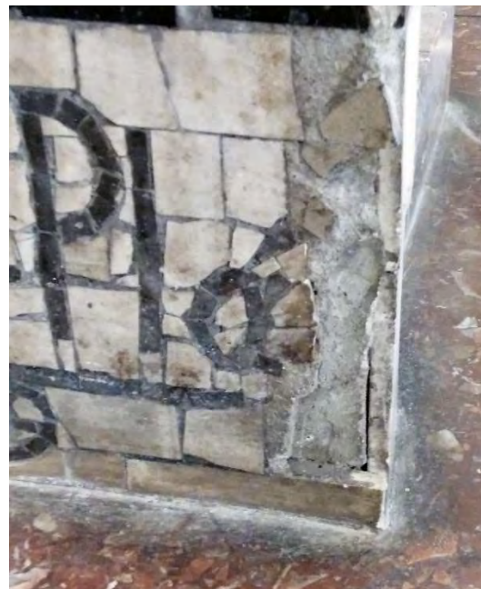
MT 6. Reompliment amb ciment d'espais on faltaven peces
