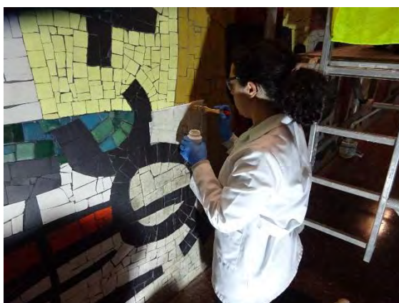
MT 22. Aplicació solució d'hiposulfit sòdic
