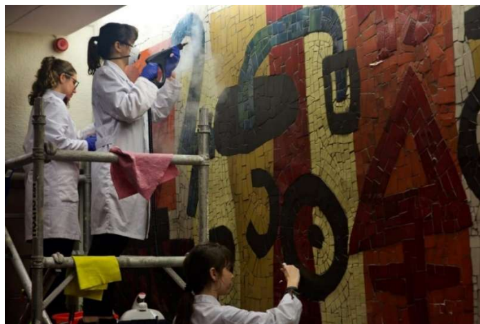
MT 21. Neteja general amb vapor i puntual amb bisturí
