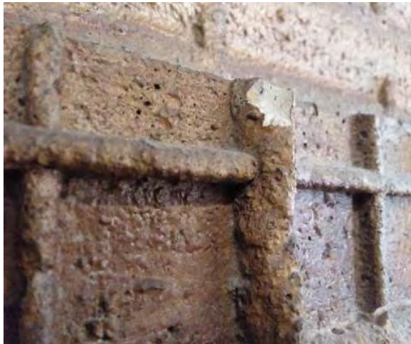
MG 34. I MG 35. Reintegració volumètrica
