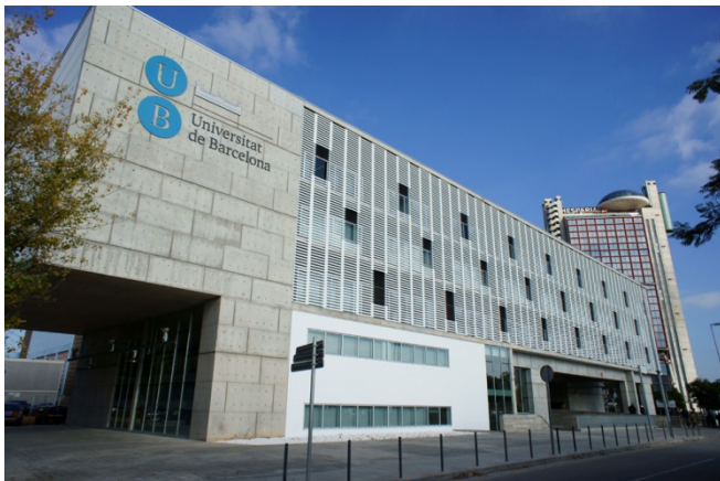
Figura 11. Façana del nou aulari de Bellvitge. Fotografia facilitada per l'Administració de Centre de Bellvitge.
