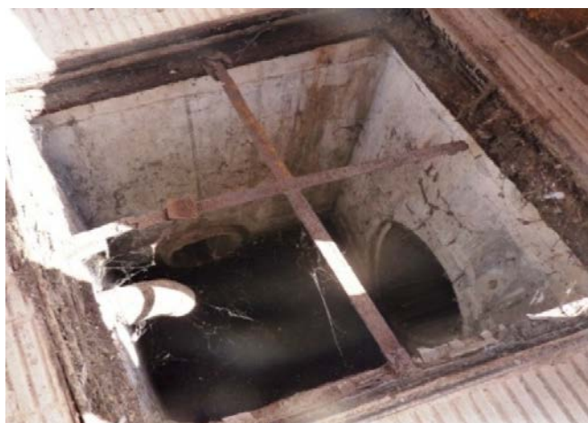
Figura 22. Registre d'aigües residuals a l'edifici B de la Facultat de Farmàcia. Autor: Adrià Riudeubàs.
