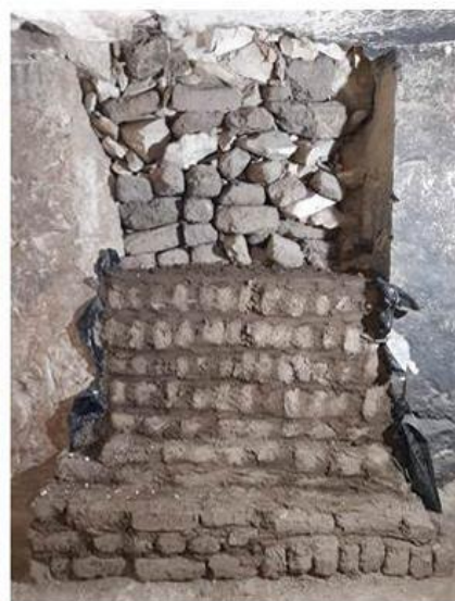
Fig. 3b. Sector II. Muro de contención con mouna ©Proyecto Amenmose
