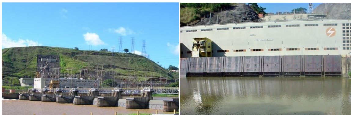
Figura 6. Estação captadora e bombeadora de Barra do Pirai e Estação Elevatória de Vigário, em Pirai
