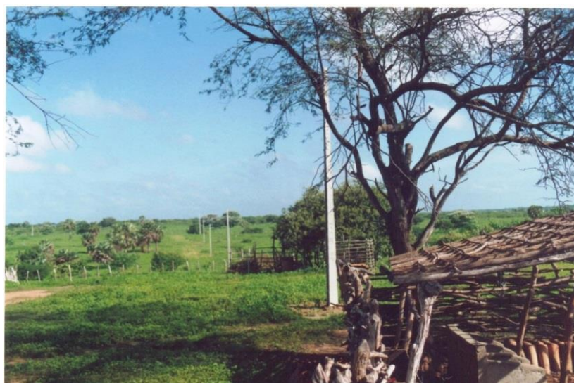
Figura 3. Itapipoca-Ceará. Processo de instalação de energia em parte da comunidade de Nova-Assis, à espera da fiação. Foto: Anselmo Alfredo, julho/2007.
