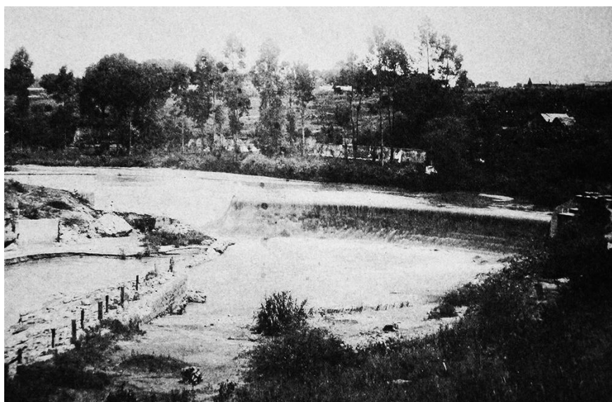
Figura 4. Presa antigua y nueva de la fábrica El Mayorazgo, c. 1890
