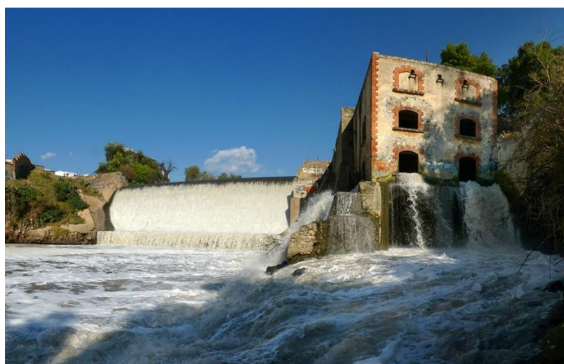
Figura 5. Planta hidroeléctrica Carmelita, 2014
