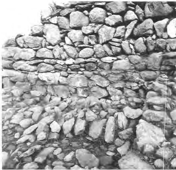
Figura 77. Detall del lligam de la torre de migdia amb la muralla (1987).
