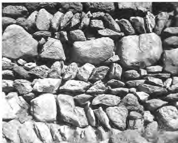
Figura 66. Exterior de la muralla al costat oest de la porta (1946).
