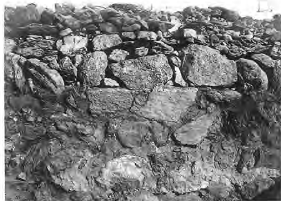
Figura 5. Fotografia D del diari de Folch i Torres: "Interior de la muralla on per efecte d'estar enterrada, se conserva la junta de les pedres amb el material, tal i com fou al exterior", pàg. 22.
