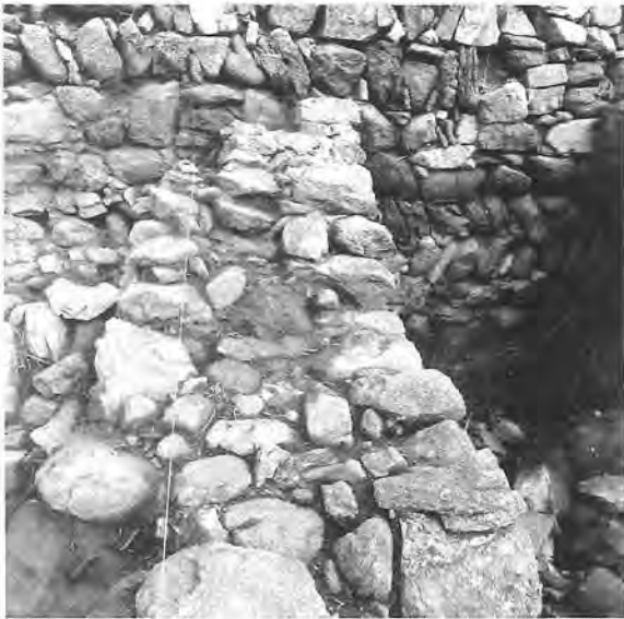
Figura 76. Mur de l'est de la caixa estructural de la torre del costat de la porta (1987).
