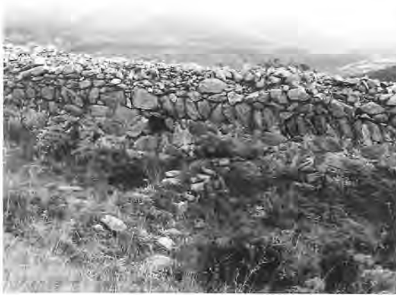
Figura 80. Vista del parament intern de la muralla a la zona excavada per Folch i Torres l'any 1917 (1987).
