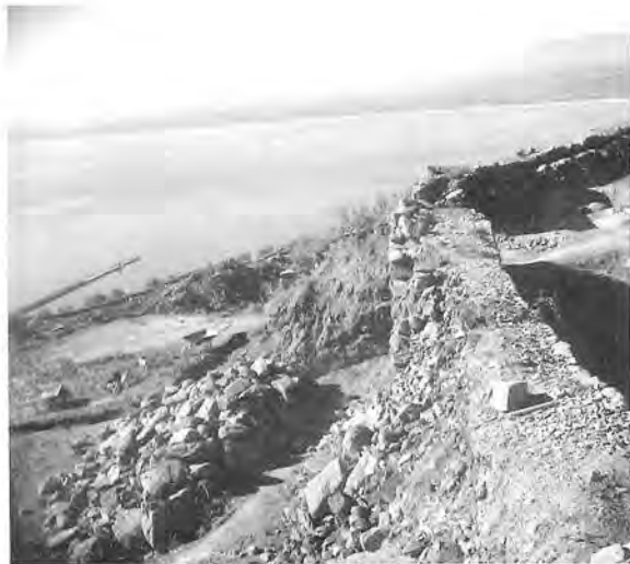
Figura 32. Parament exterior de la muralla caigut (1946).
