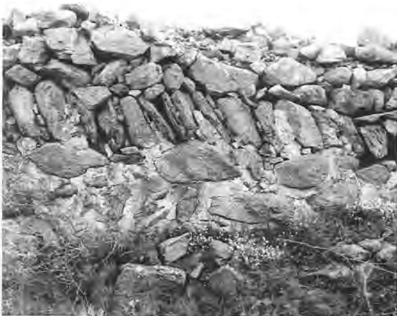
Figura 81. Detall del parament intern de la muralla a la zona excavada per Folch i Torres l'any 1917 (1987).
