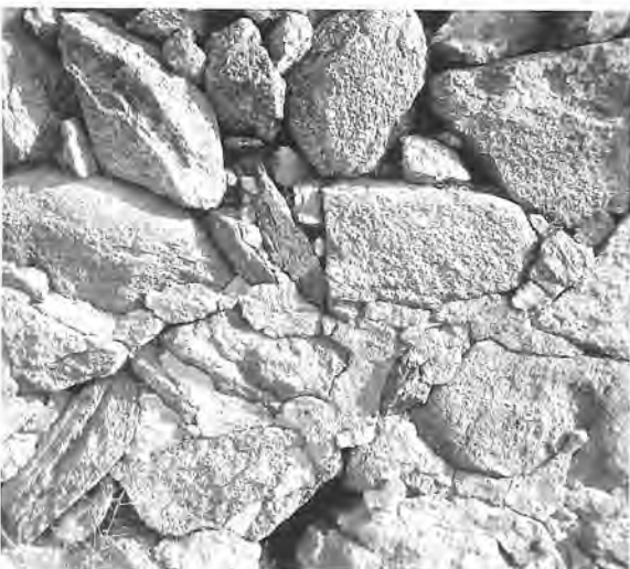
Figura 82. Detall del parament intern de la muralla amb restes de les juntes de morter de calç (1946).
