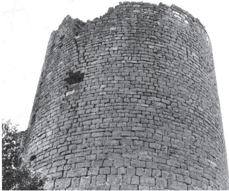
Fig. 4. Torre de Sant Jaume de Cas (La Noguera). Vista exterior.
