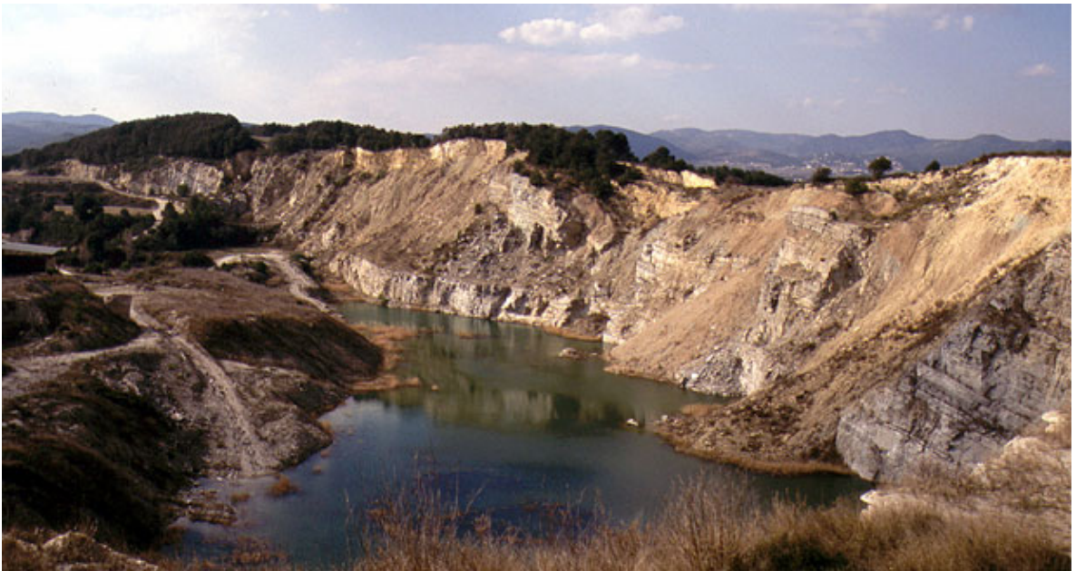
Aspecte de l'explotació abandonada. Es poden observar diversos desprendiments a la paret de la pedrera. (Foto: C. Saavedra, 2001).
