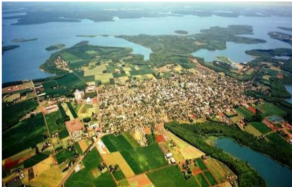
Figura 3. Vista da cidade de Santa Helena – PR e seu entorno. Fonte: Município de Santa Helena. Assessoria de Imprensa (2012).
