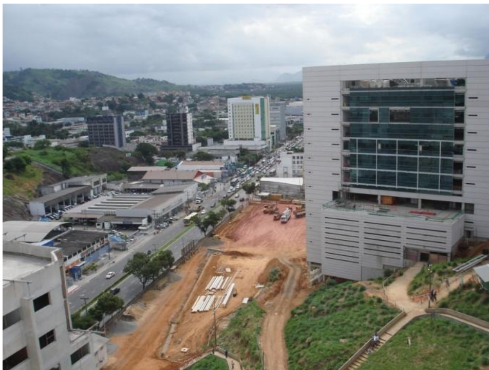
Figura 9 – Obras da construção da Unidade de Negócios da Petrobras em 2010.
