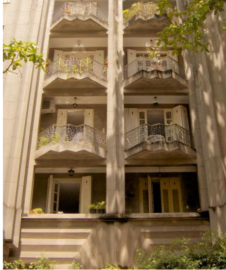
Figura 7. Edifício Guahy, no Lido, zona sul carioca: exemplo de ArtDéco
